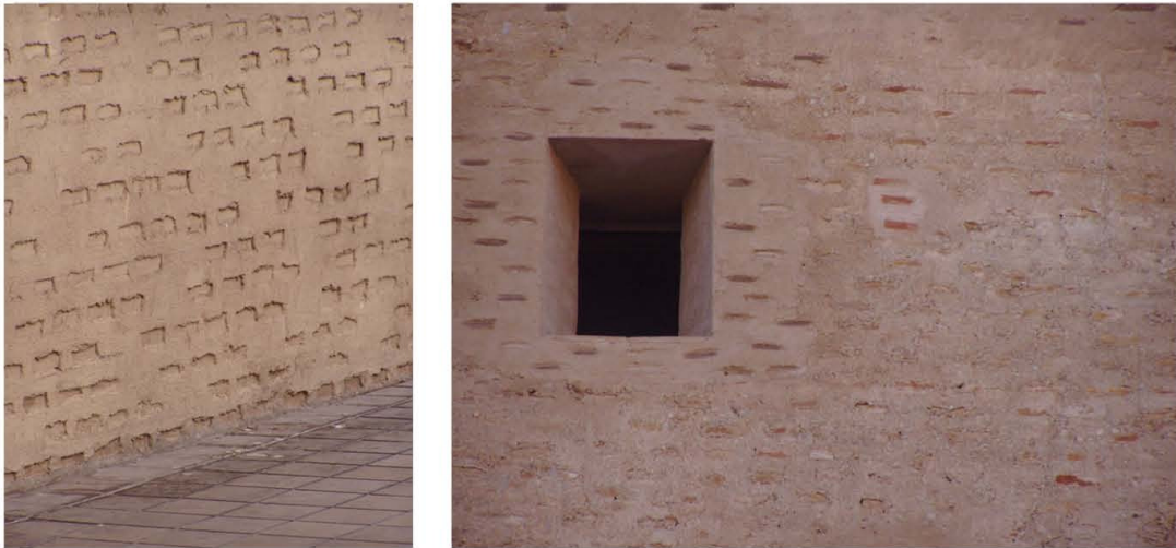
Figura 5. Esempio di edilizia residenziale realizzata in topio valenciano , esempio di restauro delle superfici non rispettoso delle finiture storiche, dettagli dettagli dell' Alqueria de Chirvell , Valencia (Cristini-Ruiz).
