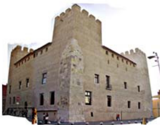
Figura 3. Esempio di un edificio significativo realizzato in tapia valenciana, in cui i muri raggiungono i 15 m di altura; Castillo de Alaquas, Valencia. (Cristini-Ruiz).
