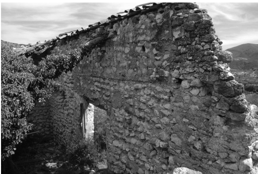
Figura 2 Tapia de argamasa con mampuestos. Despoblado de Cairo-la, Vall d'Ebo
